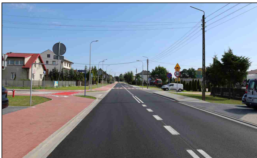
Przebudowana ul. Przemysłowa w Grajewie.
